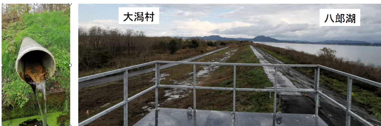
図1 左：堤防の大潟村側で浸透している八郎湖水。大潟村では堤防に沿って約1km長で堤防浸透水を集め、ポンプを使って、地下に埋設した水管を通じ浄水場まで送水している。右：八郎湖と大潟村。八郎湖の水面は大潟村の標高よりも高い。
